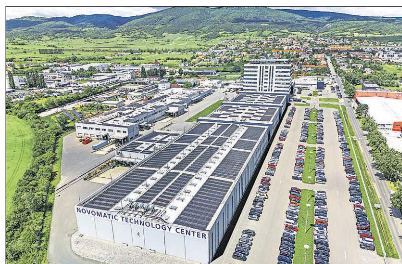
Nachhaltigkeit wird bei Novomatic groß geschrieben. Am Headquarter-Sitz in Gumpoldskirchen liefert eine PV-Anlage auf einer Fläche von 20.000 m 2 seit Sommer 2024 Ökostrom. [Novomatic]
