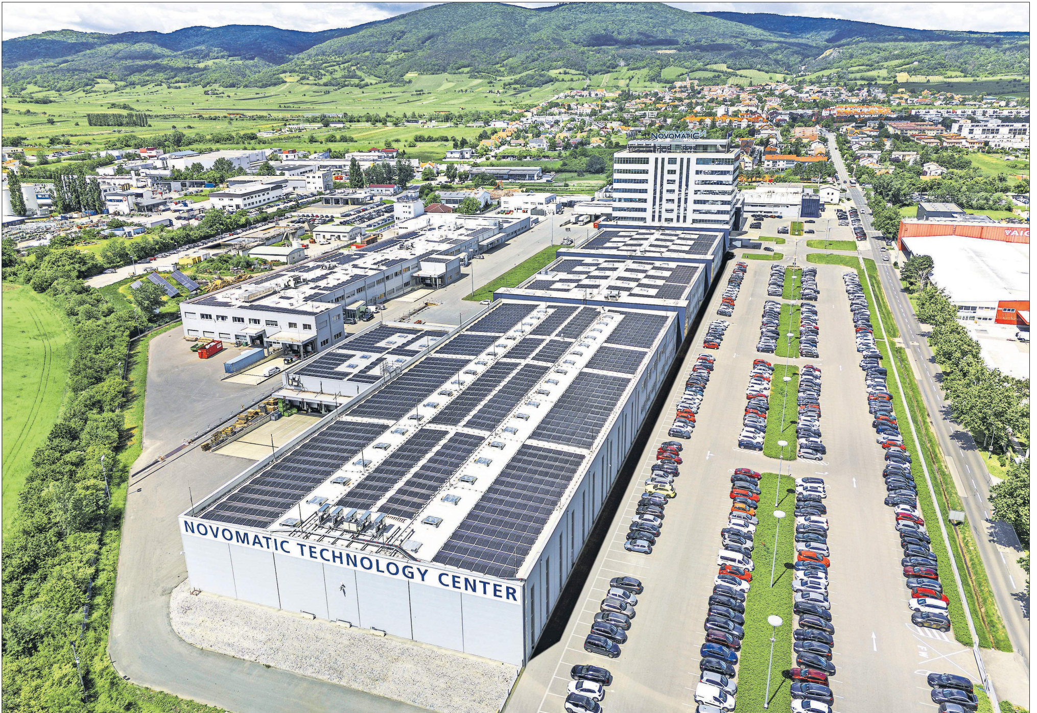
Mit einer Größe von rund drei Fußballfeldern ist die neue PV-Anlage eine der größten Aufdachanlagen Niederösterreichs. [Novomatic AG]
