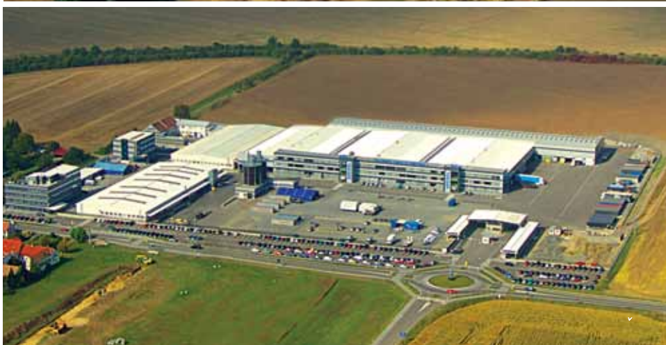
Planta EDP en Komořany.
